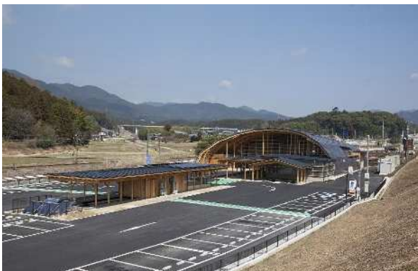
大型の木造公共施設 (新城市)
