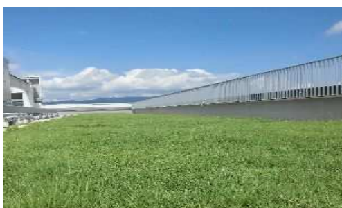
公共施設の屋上緑化（愛西市）
