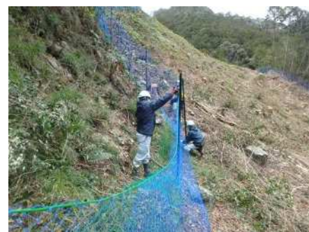
獣害防止柵の設置
